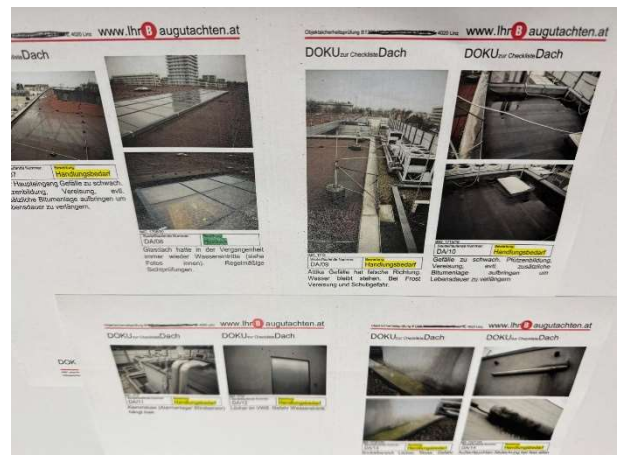
Foto mit Mängeln am Flachdach
