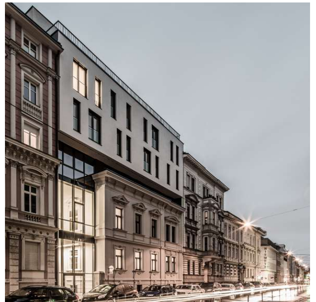
Realisierte Aufstockung – 2 Geschosse Bestand 3+Dach Erweiterung
