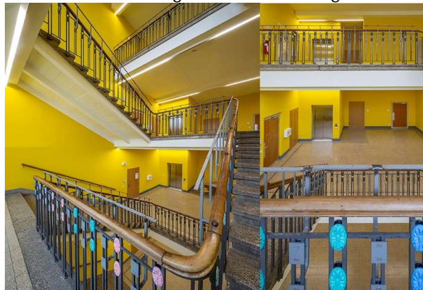
Fertiges Treppenhaus (hier noch ohne montierten Holzhandlauf)
