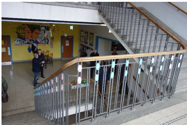
Denkmalgeschütztes Treppenhaus Schule mit Geländer
