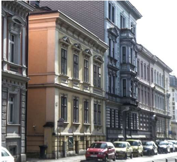
Foto Bestand ohne Aufstockung
