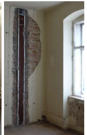
Stahlstützen im Bestand
