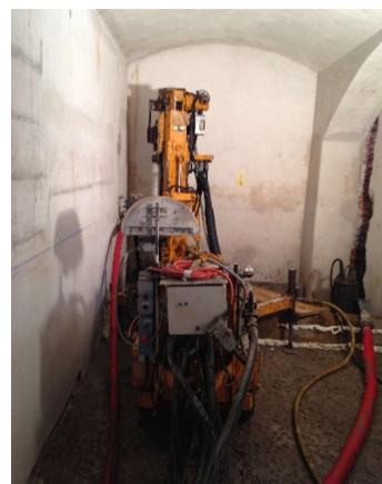
Herstellen Fundamente i Keller
