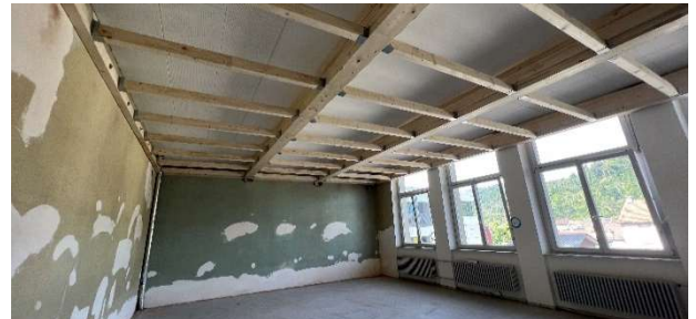
Freitragende Holzunterkonstruktion
